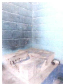
REPARACIÓN O SUSTITUCIÓN DE ÁREA DE COCINA Reparacion de estufa rural con chimenea, plancha y accesorios.
