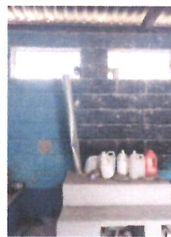
REPARACIÓN DE REPELLO Y CERNIDO DE PAREDES Reparación de repello y cernido en muro de mamposteria con aplicacion de acabado uniforme, en cocina
